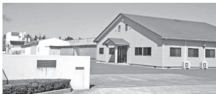
事務所棟とその奥が工場棟
