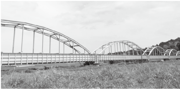
両総用水の水路橋は全長305m。この橋を通った水は千葉県の水田の二割を潤している。
